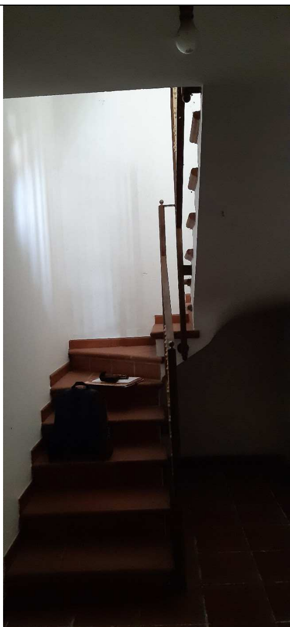
Figura 27 - arrivo scala al piano interrato
