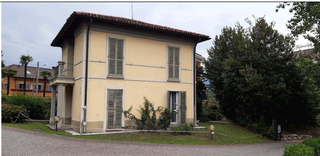
Figura 15 - vista casa del custode dal parco
